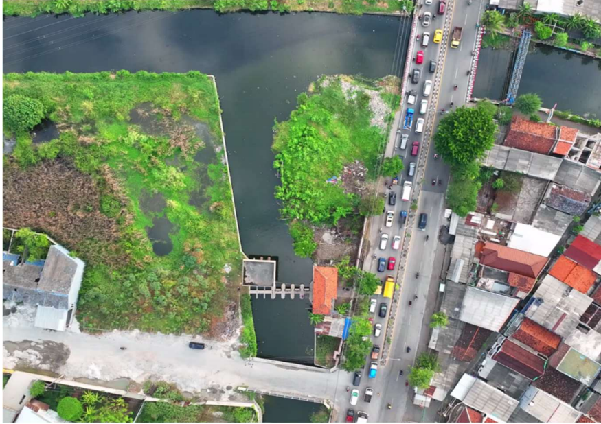
Gambar 2.26. Kondisi Eksisting Rumah Pompa Gebangsari
